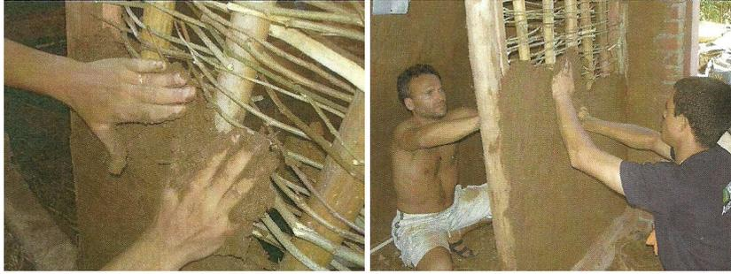
Figura 02: aplicação de terra sobre estrutura em pau-a-pique, combinando bambu e galhos tramados. Fonte: Integria.
