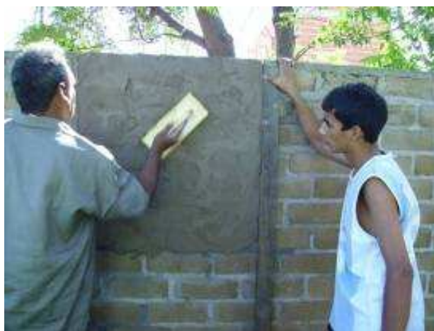
Figura 4: Revoque grueso con fratacho (Bancalari)
