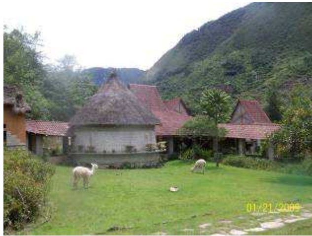
Vista exterior del museo, donde se aprecian los perfiles de las salas de exposición con los grandes techos y la recepción del museo en la edificación semicircular con cobertura de paja
