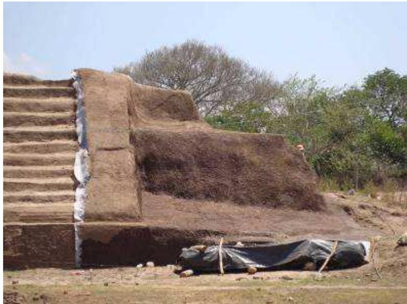
Figura 5. El revoque de sacrificio sobre el geotextil.
