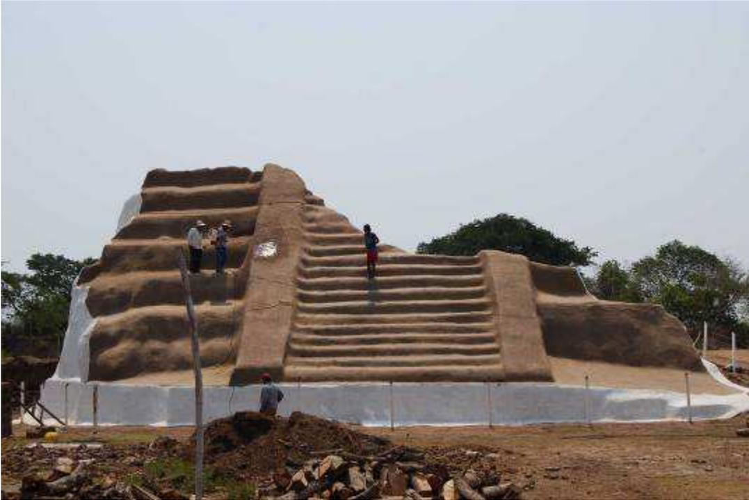
Figura 6. Aplicación de la emulsión hidrofugante por aspersión.
