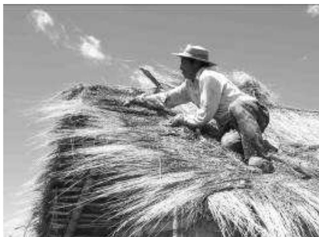
Figura 5, colocación de los aleros laterales, Rinconada 2007.
