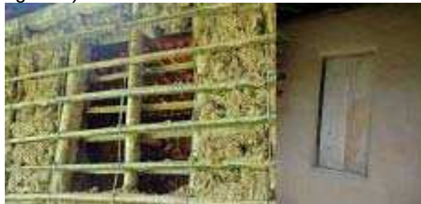
Figura 4 – Aplicação das janelas.
