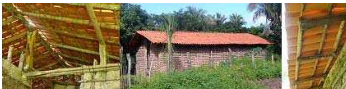
Figura 2 – Estrutura da cobertura, vista externa e beiral.
