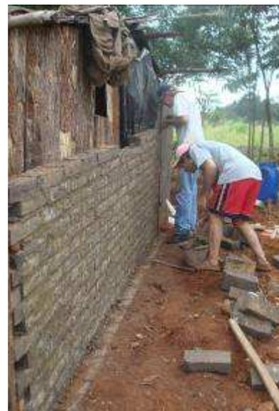
*Imag.2 construcción de nuevos muros*
