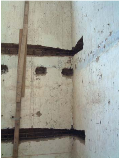
Fotografía 4. Ejemplo de llave de amarre entre muros, la fotografía muestra el momento en que está hecha la incisión en el muro (nótese la forma cónica) con la armadura de acero correspondiente, es decir previo al encofrado y la fundición con hormigón.
