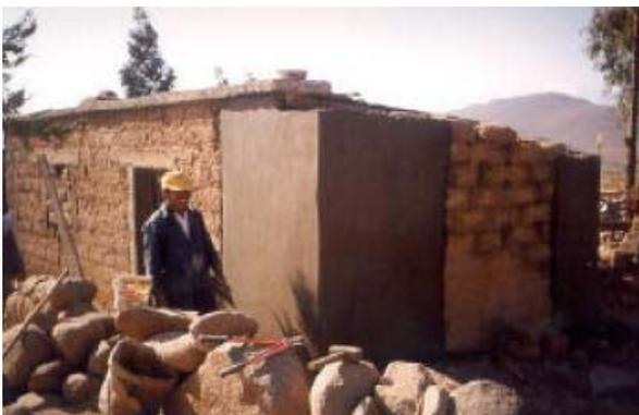
Fig. 10 - Colocação de uma camada de argamassa de cimento e areia, na zona reforçada com malha electrossoldada. *In Técnicas para el Reforzamiento Sísmico de Viviendas de Adobe*
