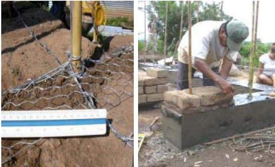
Fig. 6 - Colocação do reforço vertical com canas de bambu, e reforço horizontal com rede de galinheiro, El Salvador. *In Construcciones de Adobe Resistentes a los Terremotos*
