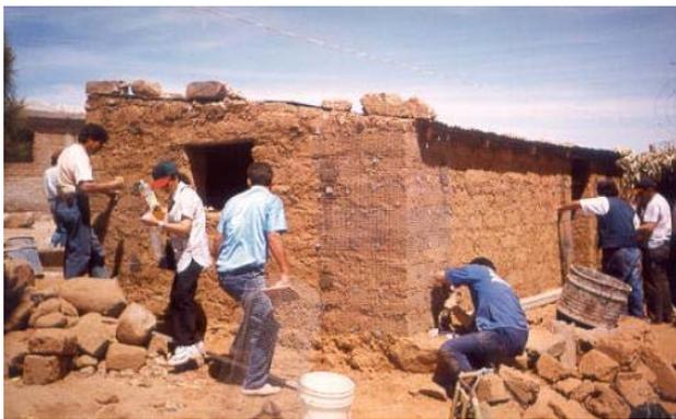
Fig. 9 - Colocação de malhas electrossoldadas em tiras verticais nas esquinas e tiras horizontais na zona superior da parede. *In Técnicas para el Reforzamiento Sísmico de Viviendas de Adobe*
