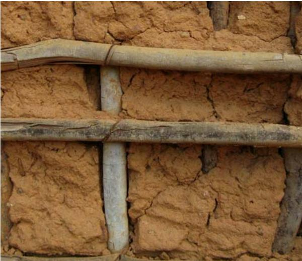
**Fig. 4 – Detalle constructivo de la taipa de sapapo (D'Aragon, J. 2004).**
