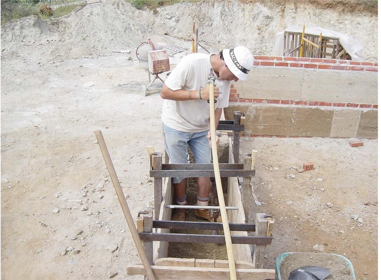
**Figura 3 – PAP: construção de um edifício em taipa**
