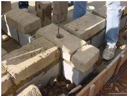
Fig. N° 3 Armado no adecuado de las juntas de bloques en contrafuertes
