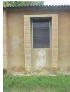
Fig. N° 4 Descontinuidad de los contrafores
