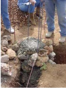
Fig. N° 1 Vaciado realizado en forma no continua
