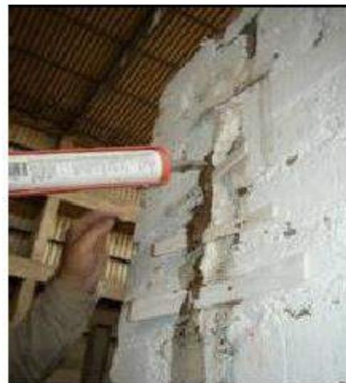
Figura 7 – Inyección de mortero
