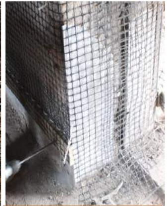
Figura 6. Sujeción geomalla en parte inferior del muro
