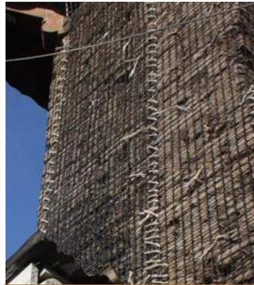
Figura 5. Retorno de la malla en esquinas (100 cm)
