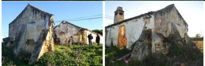
Figuras 3, 4, 5 – Habitações em taipa com introdução de elementos sísmo-resistentes, Melides. (créditos: CI-ESG, 2014)
