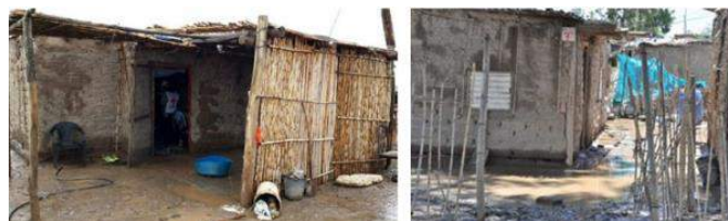
Figura 1 – Viviendas auto construidas utilizando adobes
