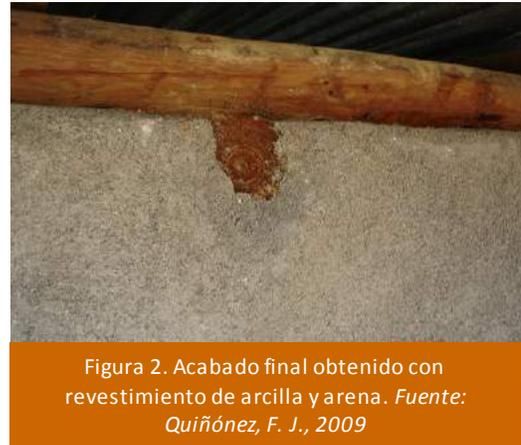
Figura 2. Acabado final obtenido con revestimiento de arcilla y arena. Fuente: Quiñónez, F. J., 2009
