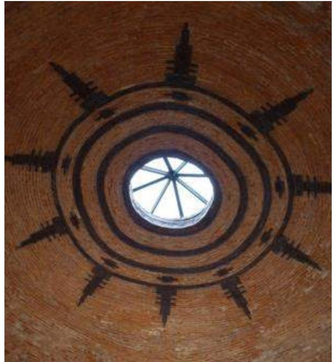
Figura 4 – Cúpula construida en ladrillo con la técnica sin formaleta, al interior de IEIASCA
