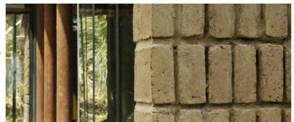
Las uniones de los adobes fueron debidamente tratadas de manera que tienen canales entre 1,5 cm y 2,0 cm de espesor y 2,0 cm de profundidad.
