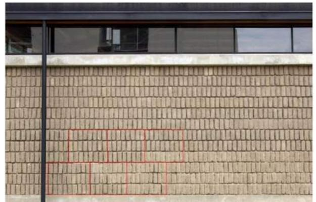
Figura 4 – Esquema de trabe entre bloques de adobes
