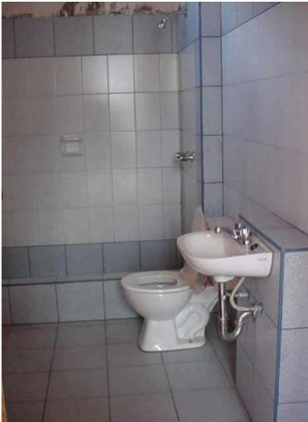
Fig : Paneles sanitarios fabricados de quincha y revestidos de cerámica para no dañar el muro de adobe
