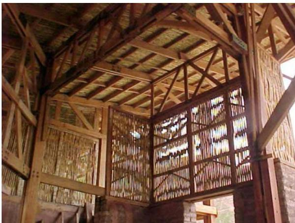
Fig. 3 : Estructura del hall principal de madera con paneles de quincha prefabricada
