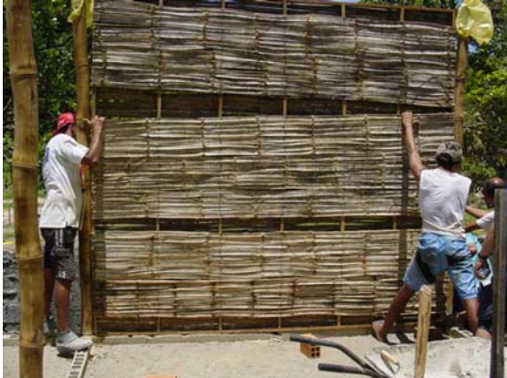
Fig. 1-Assentamento dos painéis de bambu na estrutura.
