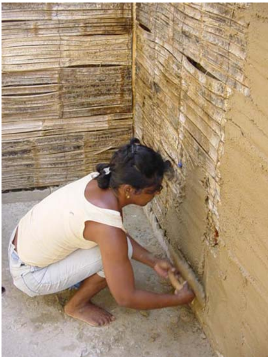
Fig. 2 - Revestimento com argamassa primeira camada.
