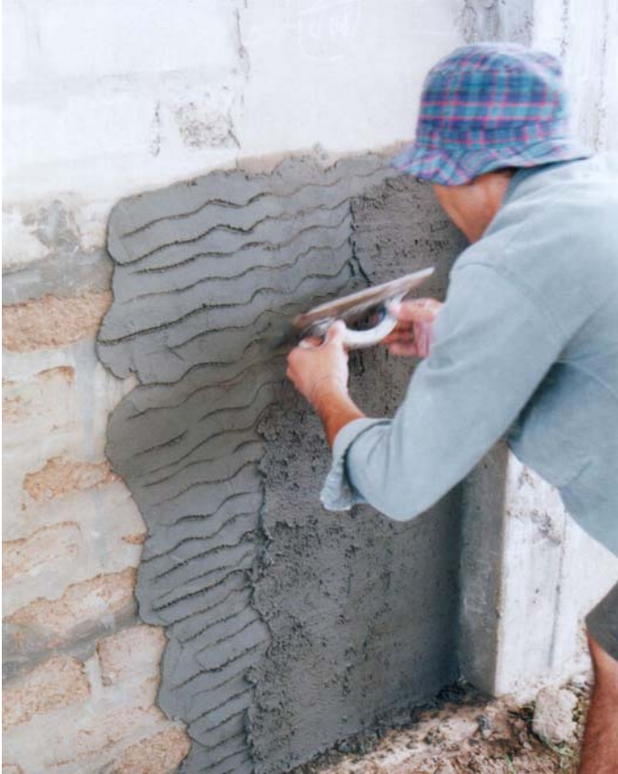
Fig. 2 – Prototipo de revoque de suelo-cemento sobre muro de BTC.
