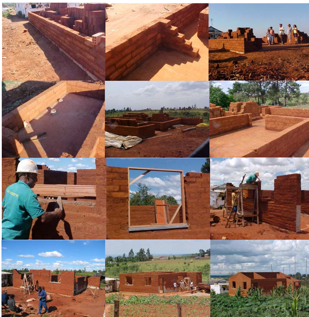
Figura 4: Fotos da seqüência de elevação da parede em adobe
