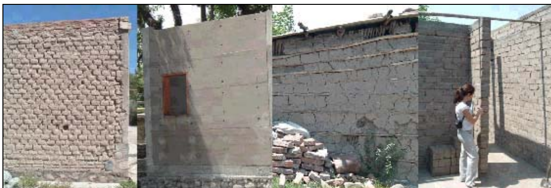
Fig.2- Muros con tecnologías de tierra: adobe en Amaicha del Valle, tapial en Famaillá, quincha y BTC en Monteros.
