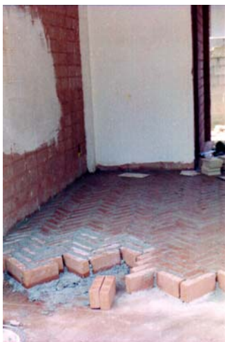
Figura 3 - Assentamento do Piso – Ilha Bela / São Paulo
