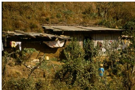
Figura 7 – Vivienda de madera. Infestada
