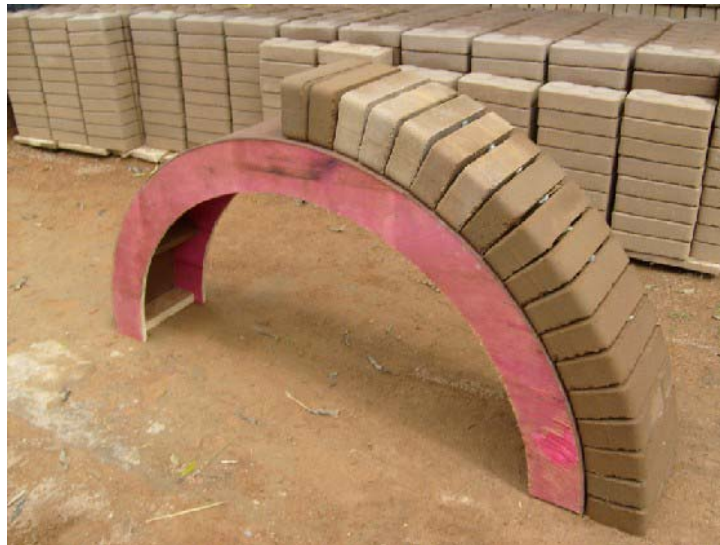
Figura 5 – Produção de BTC local e experimentação construtiva com arcos durante oficina de capacitação
