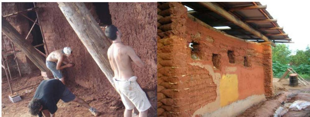
**Figura 6** – Paredes de superadobe com provas de reboco – IMCA
