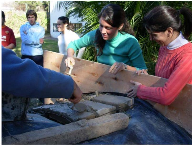
Figura 5 – Dovela de ladrillos de adobe estabilizado
