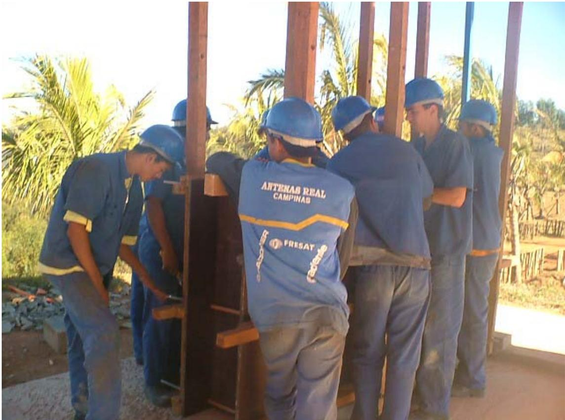
**Figura 4** – Montagem de forma de taipa de pilão
