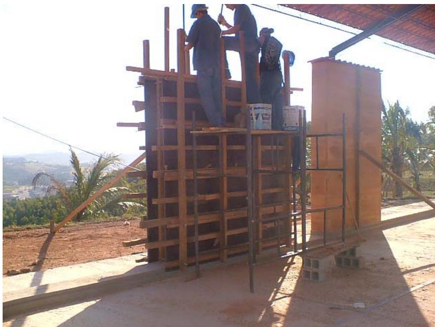
**Figura 5** – Apiloamento de parede em taipa de pilão
