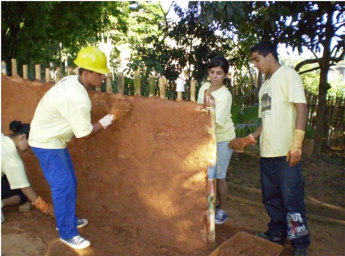
**Figura 2** – Barreamento de parede em pau a pique
