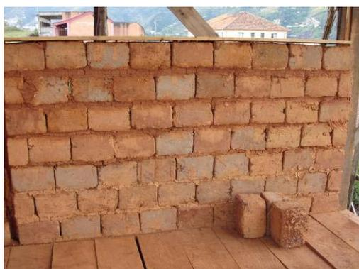
Figura 1 – Confeção de adobes para execução de parede
