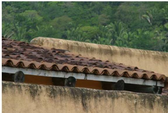
**Figura 6** – Humedad y hongos por falta de capotes en los cantos de muros y escurrimiento de aguas lluvias
