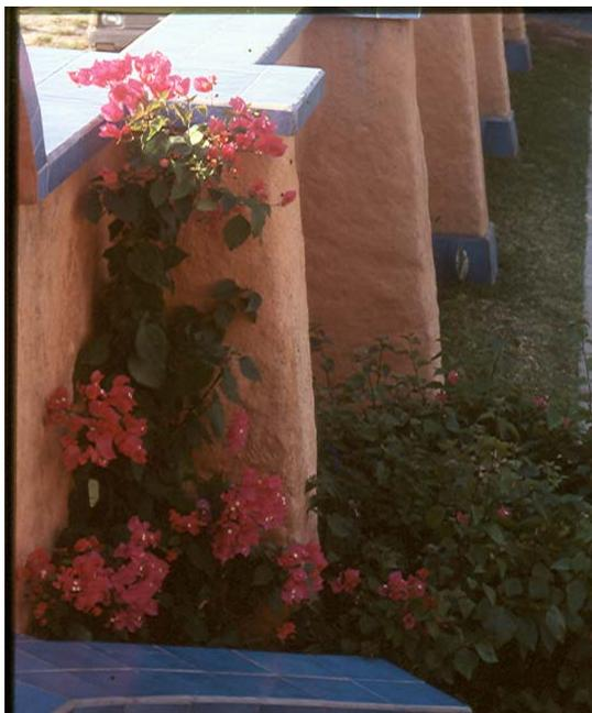
**Figura 8** – Sección de muro con contrafuertes con capote (protección de cantos de muro contra humedad), botas (zócalos o rodapié), repello cementoso con pulido de tierra y cal, ajardinado con plantas que no requieren riego directo en el trópico como las buganvillas
