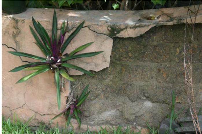
**Figura 1** – El Trópico favorece la vida, inicia con el mocho, aparecen las grietas, nace la flora y llega el posterior colapso, primero del repello y luego del muro completo
