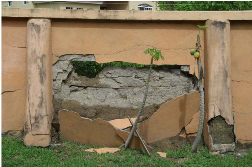
**Figura 2** – Colapso por exceso de humedad, ya que se repelló solo una cara del muro, la visible hacia la casa
