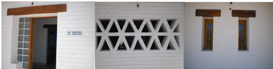
Figura 5 – Viga de madera en dinteles. Nido de abejas en lavadero
