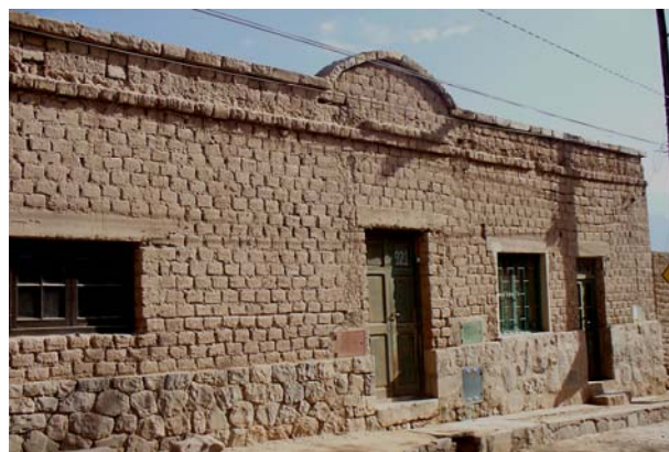
Figura 2 – Casa de adobe y techo de torta. Tilcara, Quebrada de Jujuy
