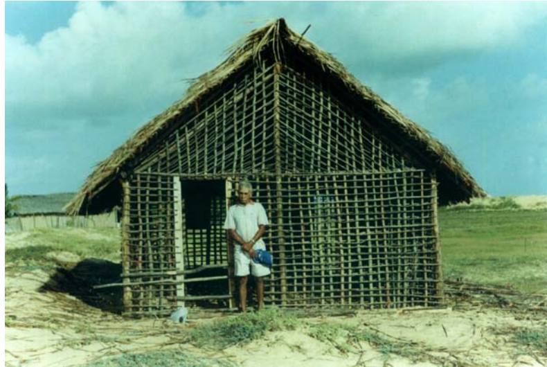
Figura 1 – Casa pronta para o tapamento
