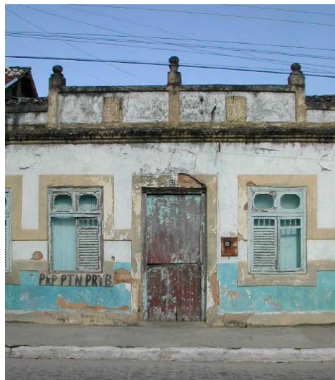
Figura 4 – Casa térrea em partido de morada inteira construída em taipa e tijolos com coberta em duas águas; cumeeira paralela à fachada; sem beiral e uso de platibanda decorada
