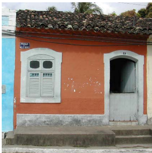
Figura 3 – Casa térrea em partido de meia-morada construída em taipa; coberta em duas águas; cumeeira paralela à fachada; beiral em beira-seveira
