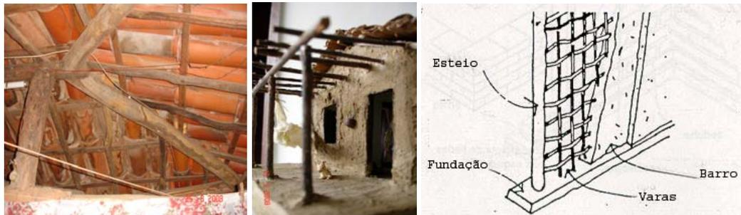
**Figura 6** – Estrutura da cobertura e das paredes
