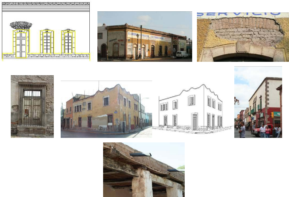
Figura 2 – El sistema constructivo en casas de uno y dos niveles en adobe, con marcos de cantería, sobrecimiento de piedra y el techo de terrado. San Luis Potosí
