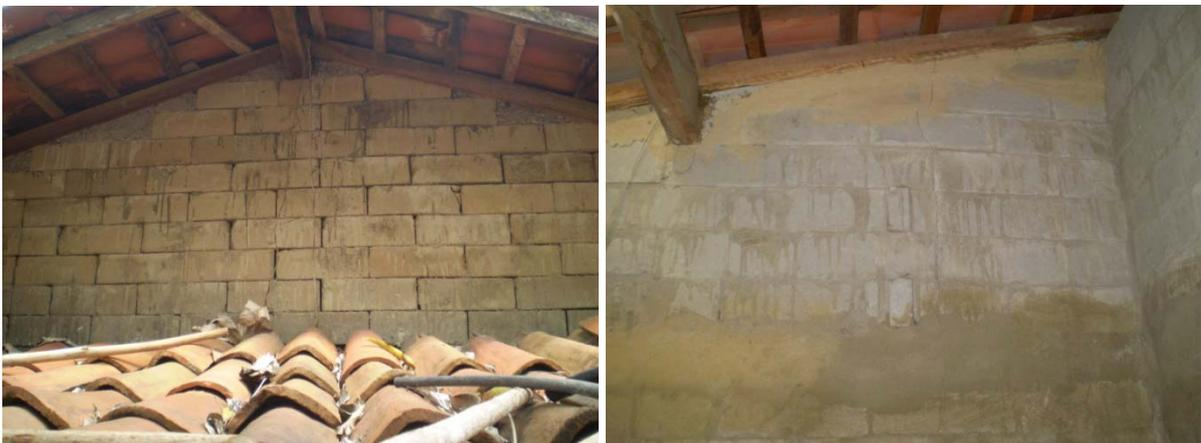
**Figura 12** – Falta de limpeza da alvenaria quando da execução
