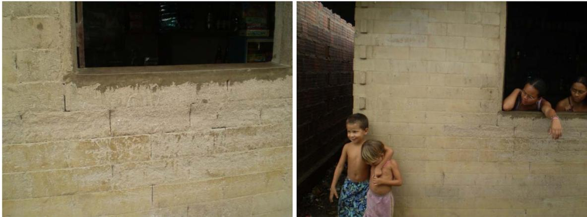
**Figura 10** – Locais com desgaste abrasivo dos tijolos
