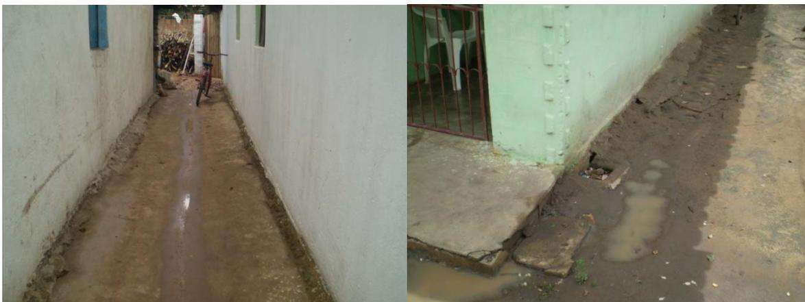
**Figura 15** – Trecho com a base das paredes bem protegida por argamassa direcionando as águas (esquerda) e trecho permitindo infiltração de água na base da alvenaria
