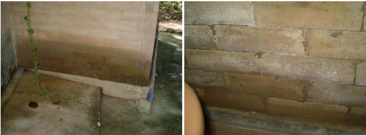
**Figura 11** – Paredes com excessivo contato com água de respingos de chuva e com manchas de lixiviação na parte interna
