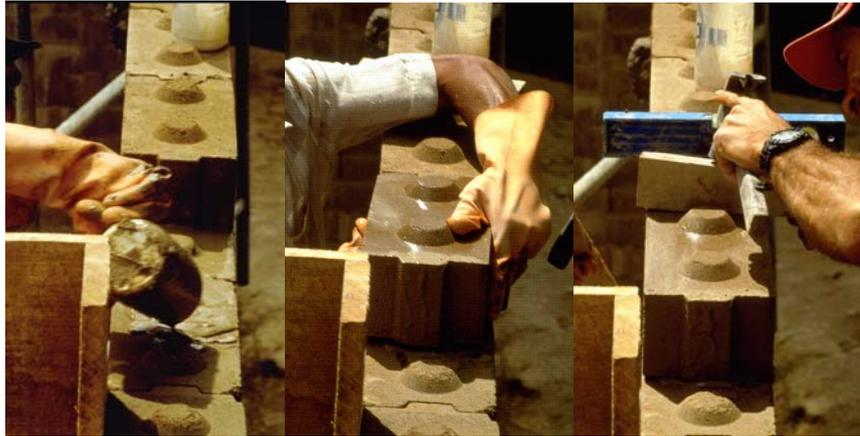
**Figura 1** – Blocos Mattone e execução de alvenaria
