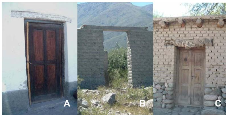
**Figura 6** – Distintos casos registrados: A- muro adobe-dintel madera (sección rect. doble); B- muro adobe con ceniza-dintel hormigón armado; C- muro adobe-dintel madera (rollizo tallado)
