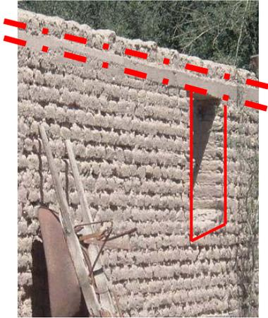
**Figura 3** - Estructura sismorresistente de hormigón armado cumple la función de dintel
