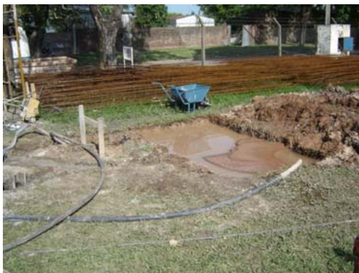
Figura 3 – Barros de excavación de pilotes
