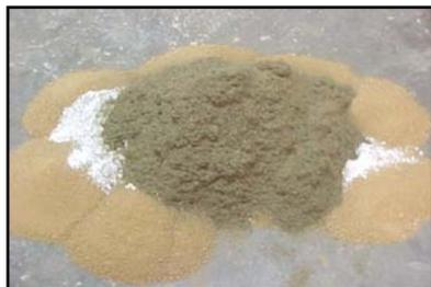
**Figura 6** – Mezclado en seco
