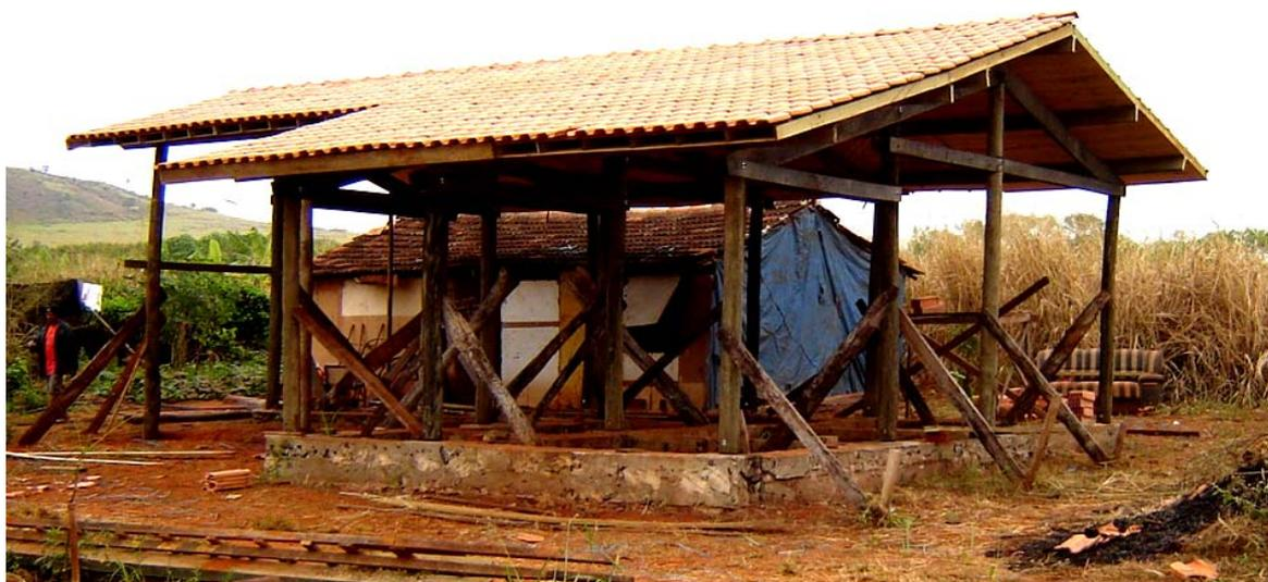
Figura 1 – Casa com sistema estrutural pilar-viga
