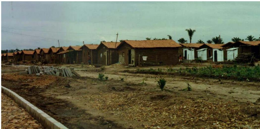
**Figura 2** – Conjunto Parque Wall Ferraz, todo construído com taipa de mão, em 1996
