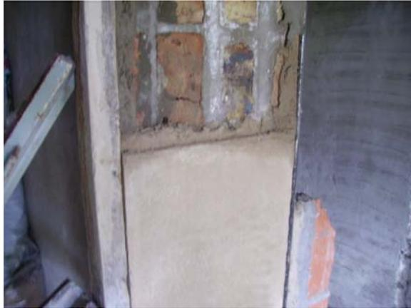
**Figura 6** – Revoque bicapa con tosca estabilizada sobre ladrillo cocido común
