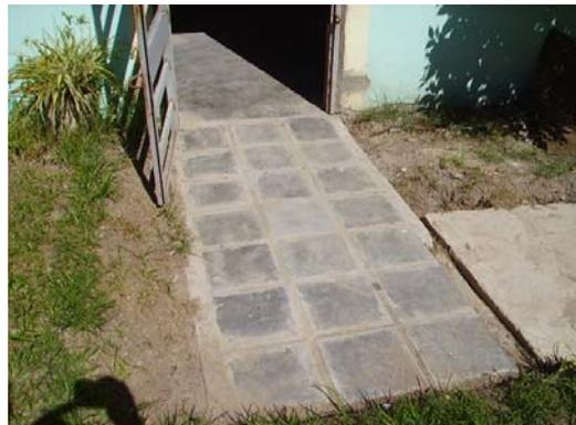
**Figura 4** – Piso terminado con junta con mortero cementicio
