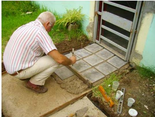
**Figura 3** – Colocación de las baldosas con mortero de tosca estabilizada
