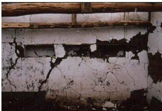
Figura 8 – El tamaño del vano se transforma en un plano de falla
