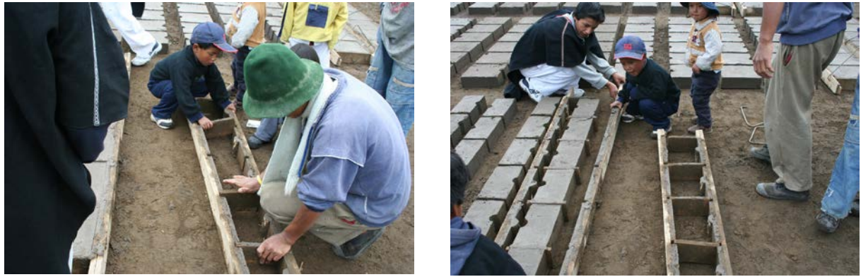
Figura 13 – Elaboración de adobes en una escuela rural
