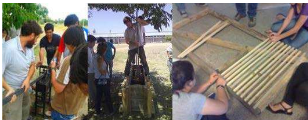
Figura 2. Talleres de BTC, de tierra apisonada y de sistemas mixtos materia optativa Arquitectura con tierra cruda Escuela de Arquitectura UNLaR.
