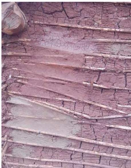
Figura 4. Prueba de revoques de tres tipos sobre Opy, junio 2016.
