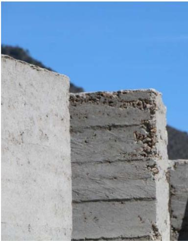
Figura 2. Muro de tapia de cal y piedra pómez.
