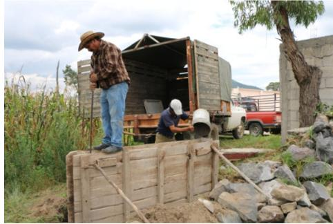
Figura 6. Procedimiento constructivo, encofrado de madera y apisonado
