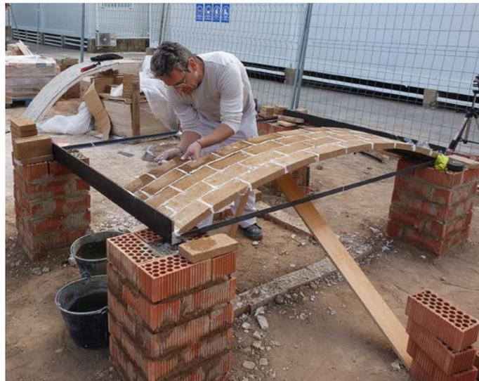
Figura 2. Construcción de una bóveda de cañón de BTC con motivo de la preparación de la colaboración de la UPV en el pabellón “Beyond bending” de OBD (Ochsendorf, Block & DeJong) en la Bienal de Arquitectura de Venecia 2016 (Fotografía: S. Tomás Márquez)
