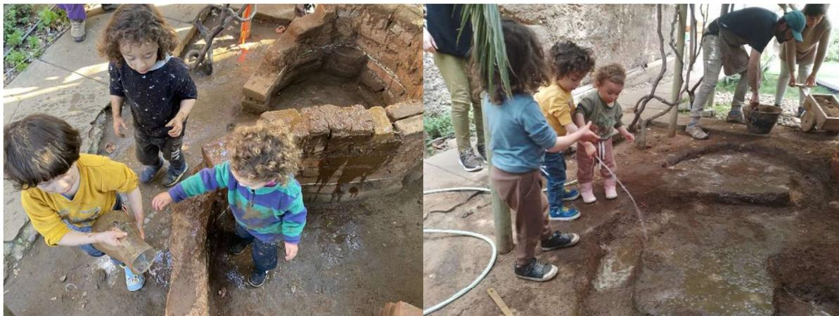
Figura 7. Preparación de la fundación y pegado de adobitos
